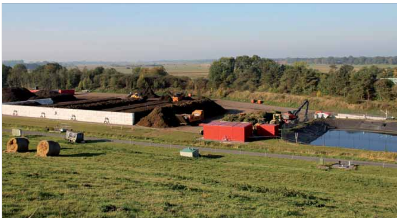
Grünabfallkompostierungsanlage am Standort Großefehn.
