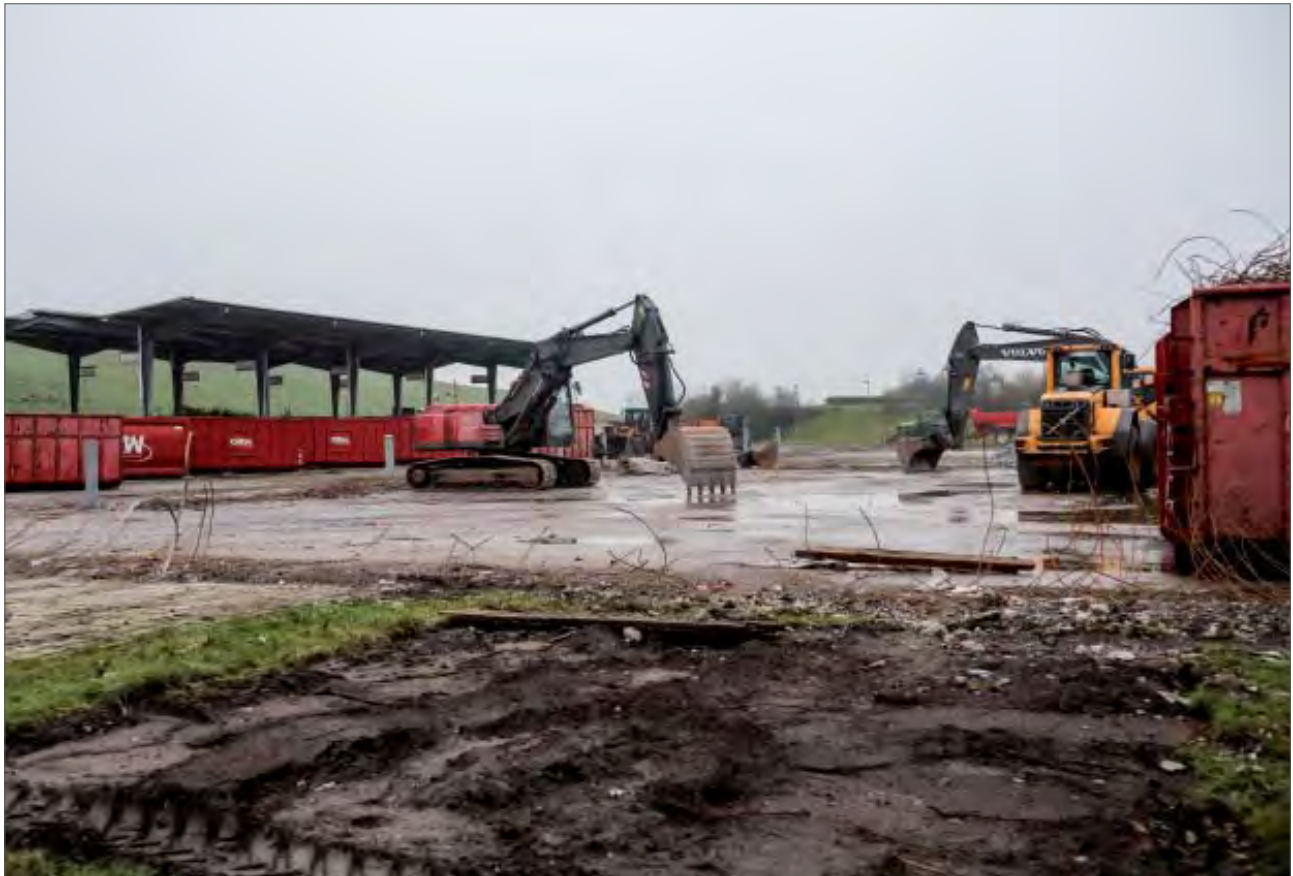
Abrissarbeiten an der abgebrannten Halle West.
