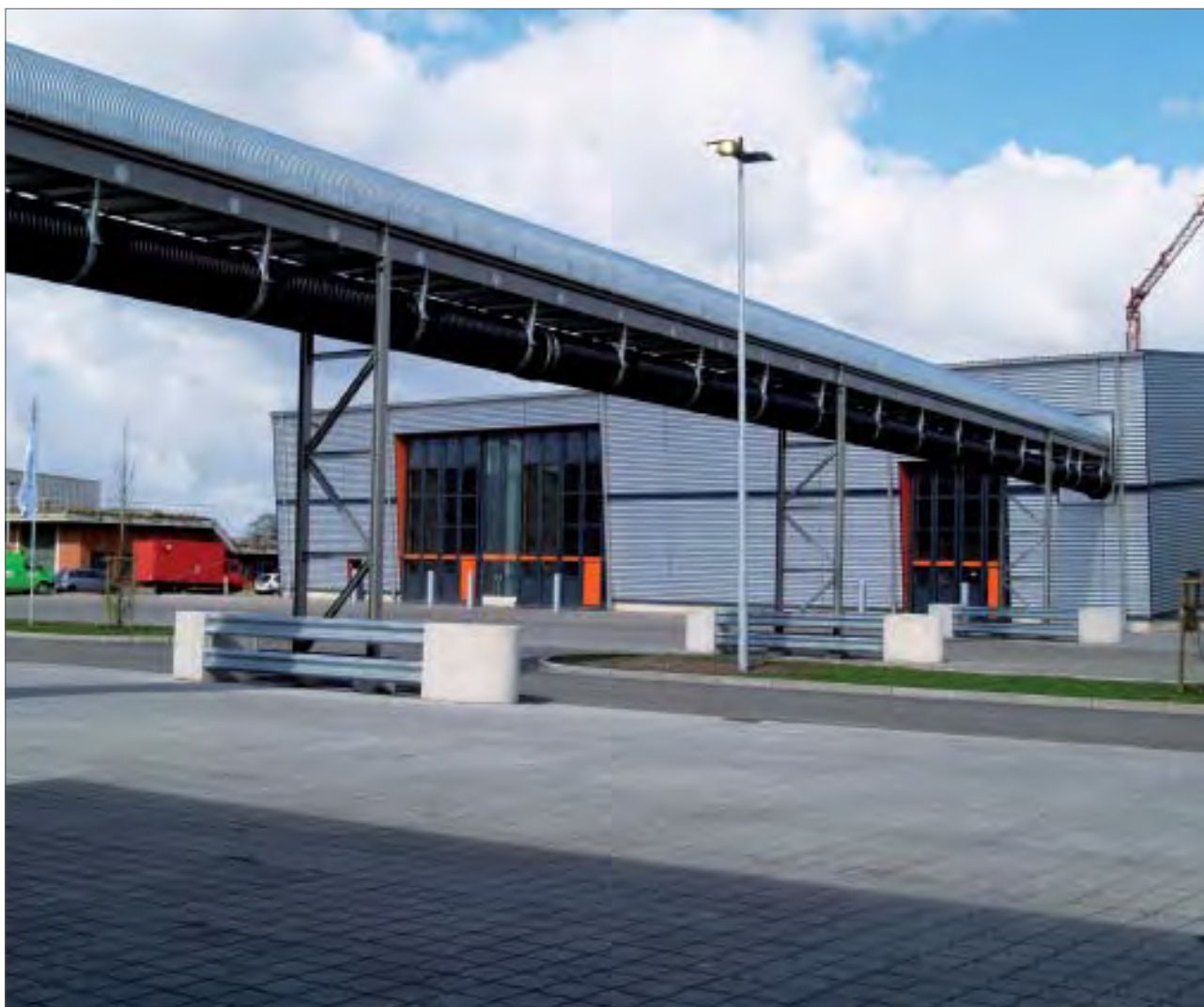
Halle der Mechanisch-Biologischen Abfallbehandlungsanlage (MBA).
