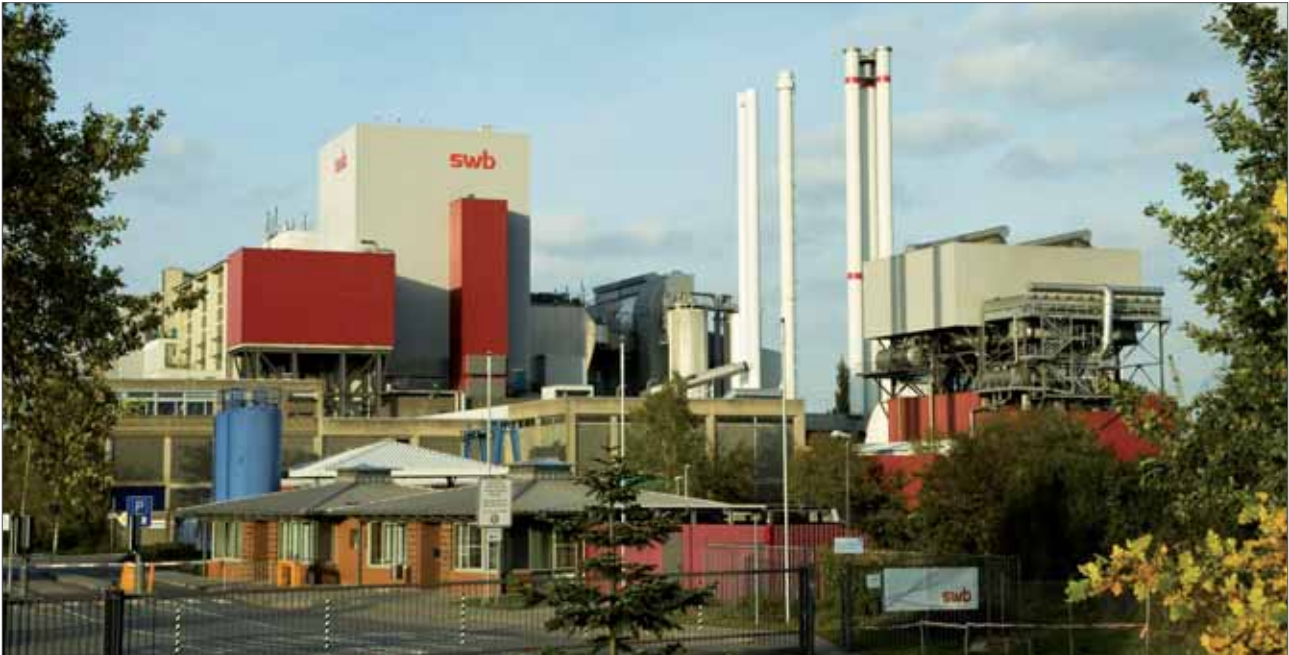
Kraftwerk der Firma swb in Bremen.
