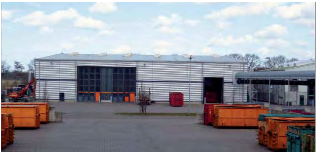
Halle der Mechanisch-Biologischen Abfallbehandlungsanlage (MBA).
