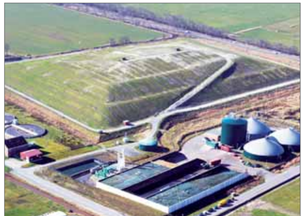
Die ehemalige Deponie Hage.
