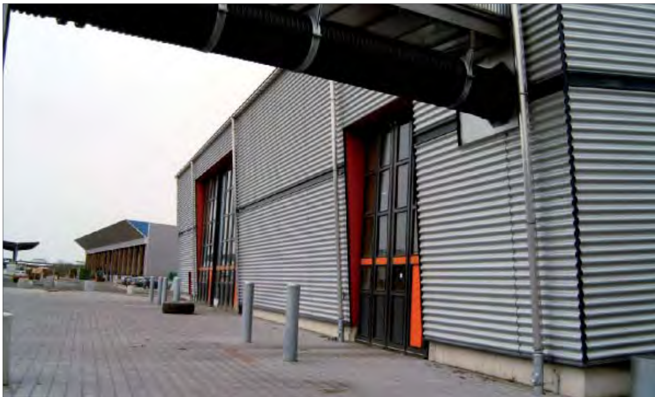
Halle der Mechanisch-Biologischen Abfallbehandlungsanlage (MBA).
