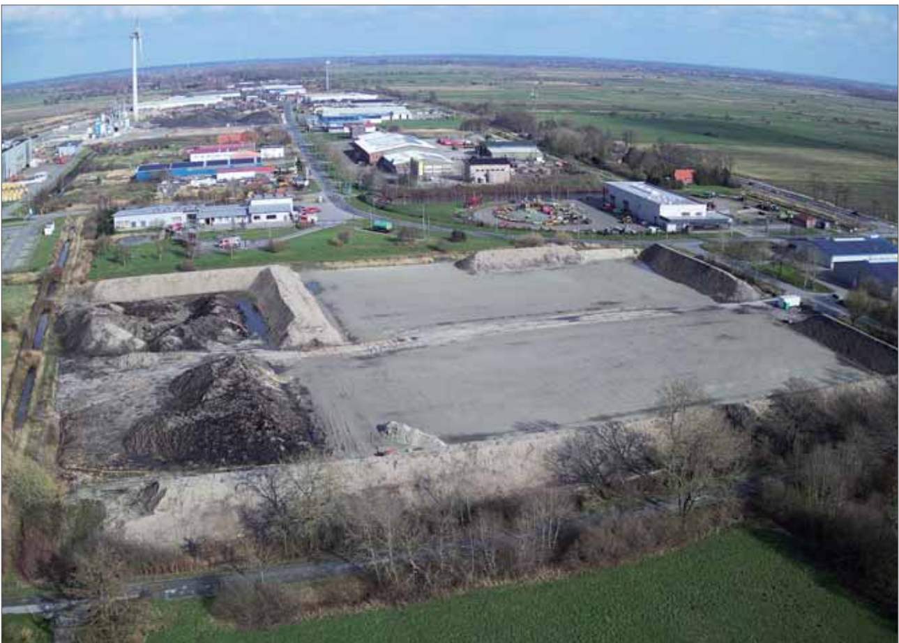
Vorarbeiten für den Wertstoffhof Georgsheil: Bodenaustausch und Errichten der Lärmschutzwälle.
