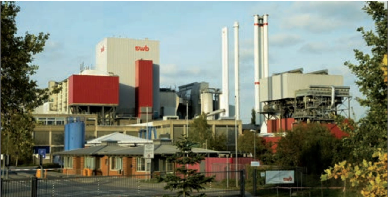
Kraftwerk der Firma swb in Bremen
