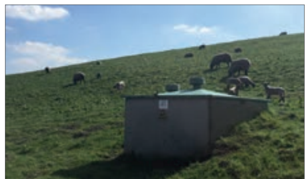
Überwachung der Altdeponien mithilfe von Brunnen
