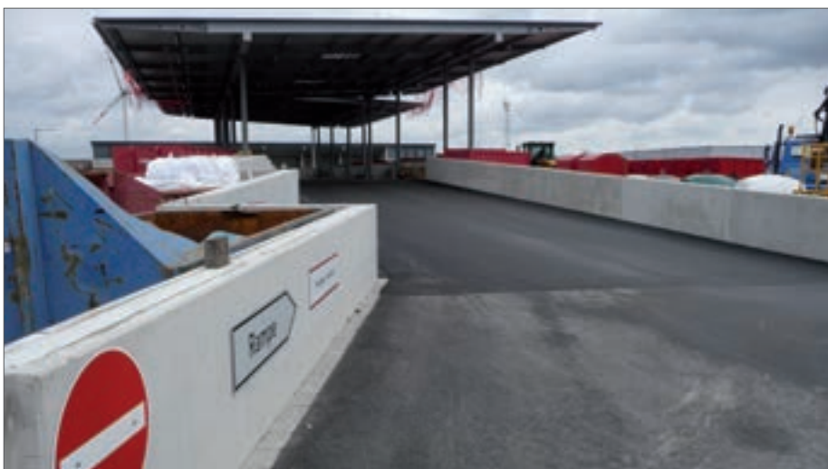
Rampe des neuen Wertstoffhofs in Georgsheil
