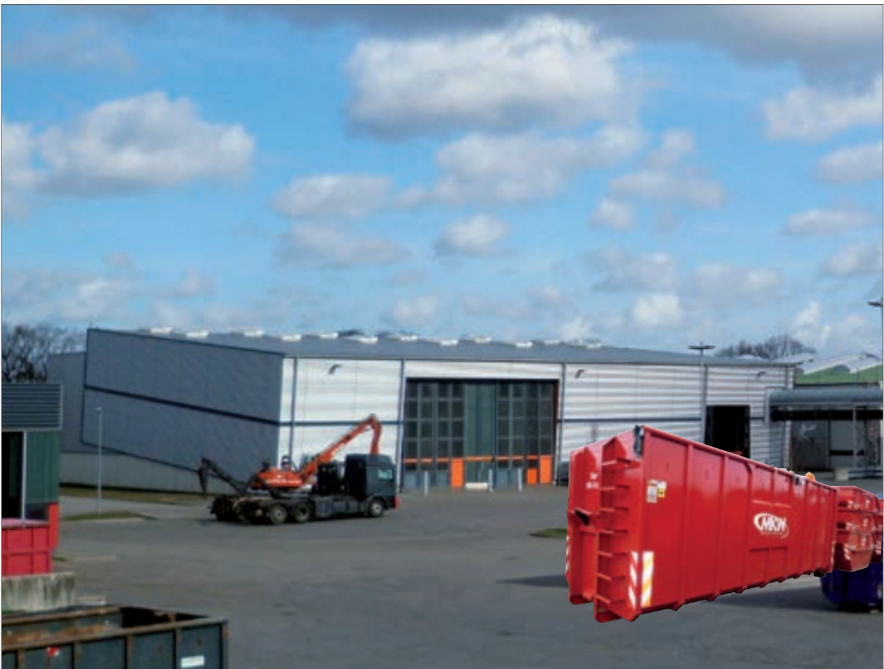
Halle für die mechanische Aufbereitung von Hausmüll
