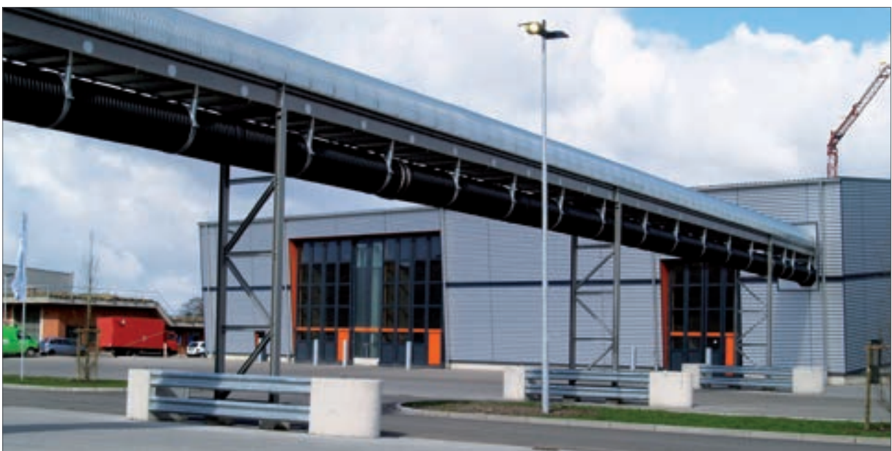
Halle für die biologische Aufbereitung von Hausmüll
