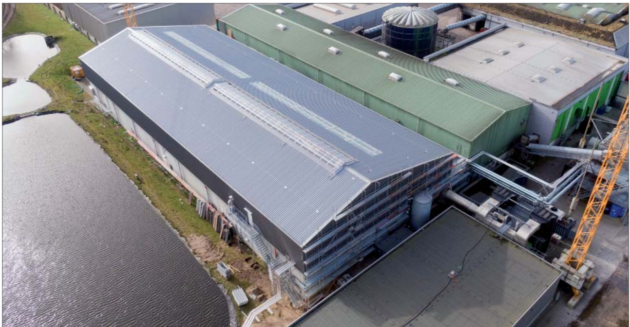
Halle des zusätzlichen Biogasspeichers
