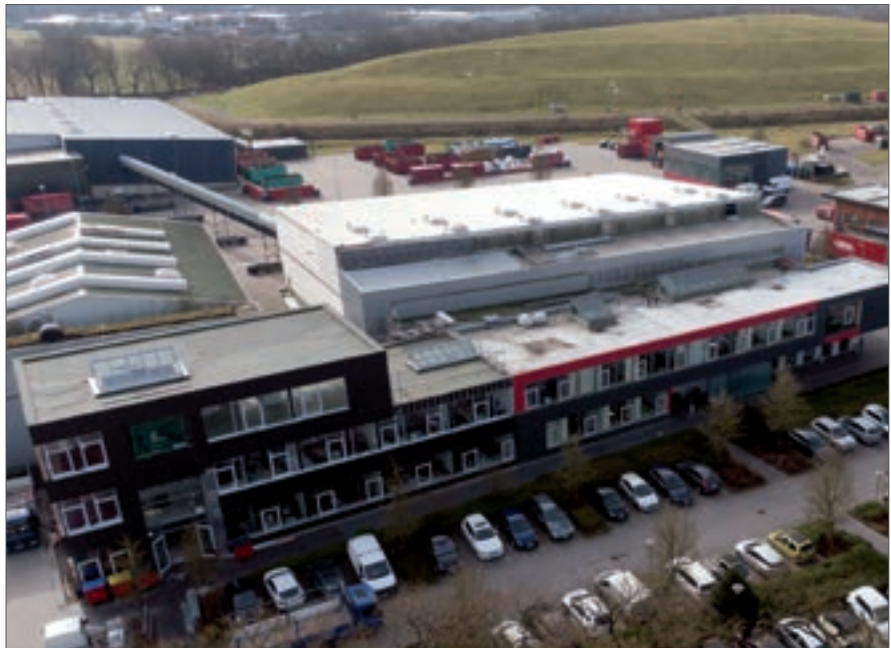
Der Erweiterungsbau für das Verwaltungsgebäude wurde fertiggestellt
