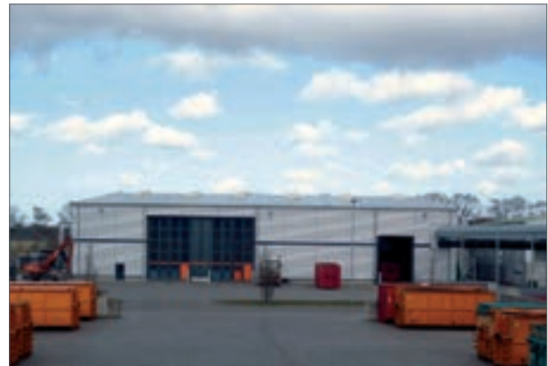
MBA-Halle mit Containern
