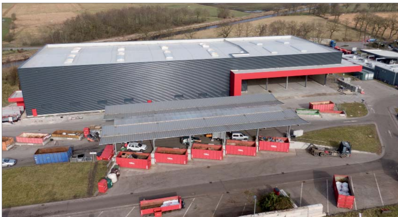
Die nach einem Brandschaden neu errichtete Halle West
