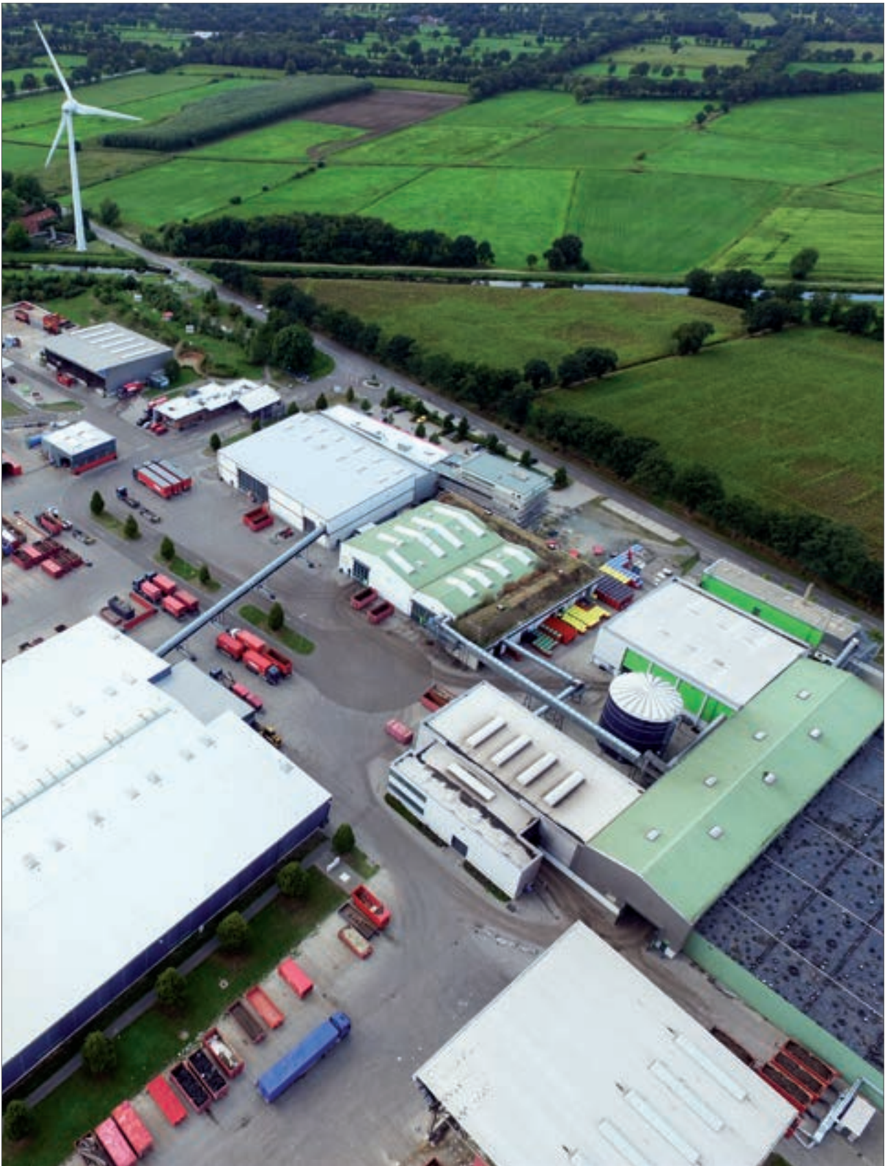
Die Abfallbehandlungsanlagen in Großefehn
