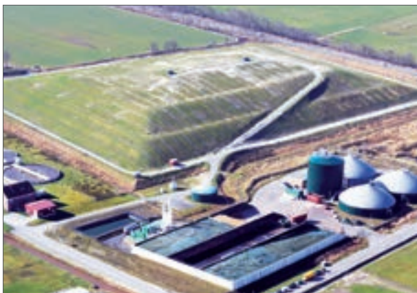
Die ehemalige Deponie Hage
