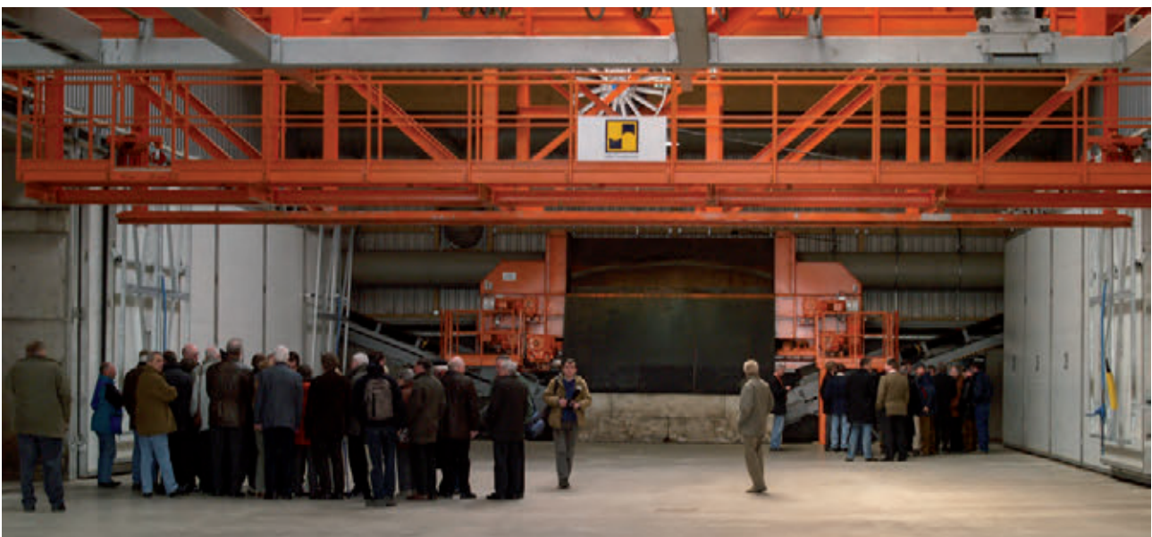
Rottehalle der biologischen Aufbereitung der MBA mit Aufgabedosierer am Ende der Halle
