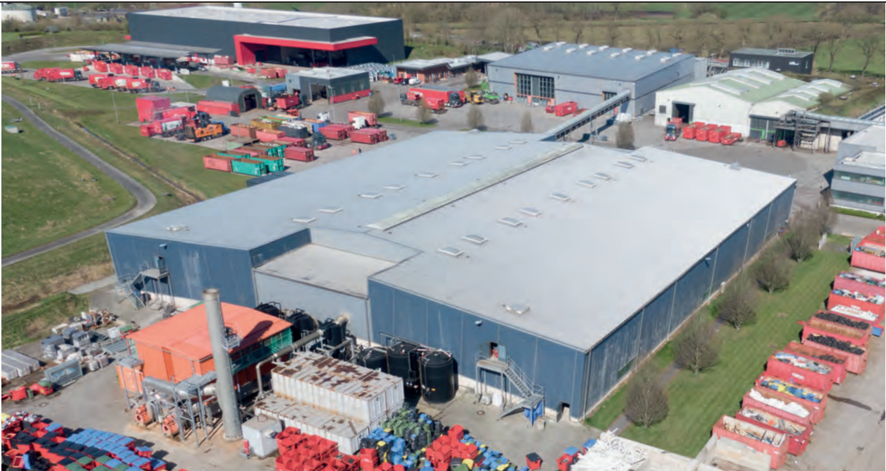
Dachfläche der biologischen Aufbereitungsanlage der MBA
