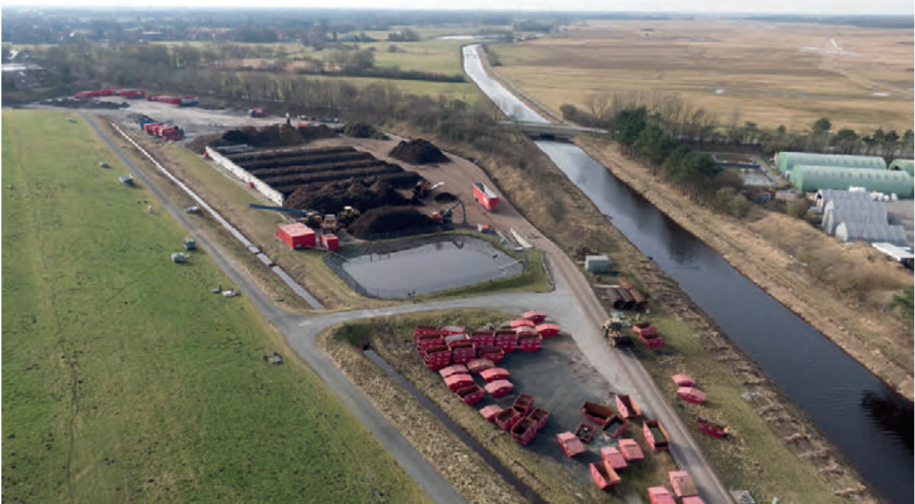
Grünabfallkompostierungs-Anlage und Containerlager in Großefehn
