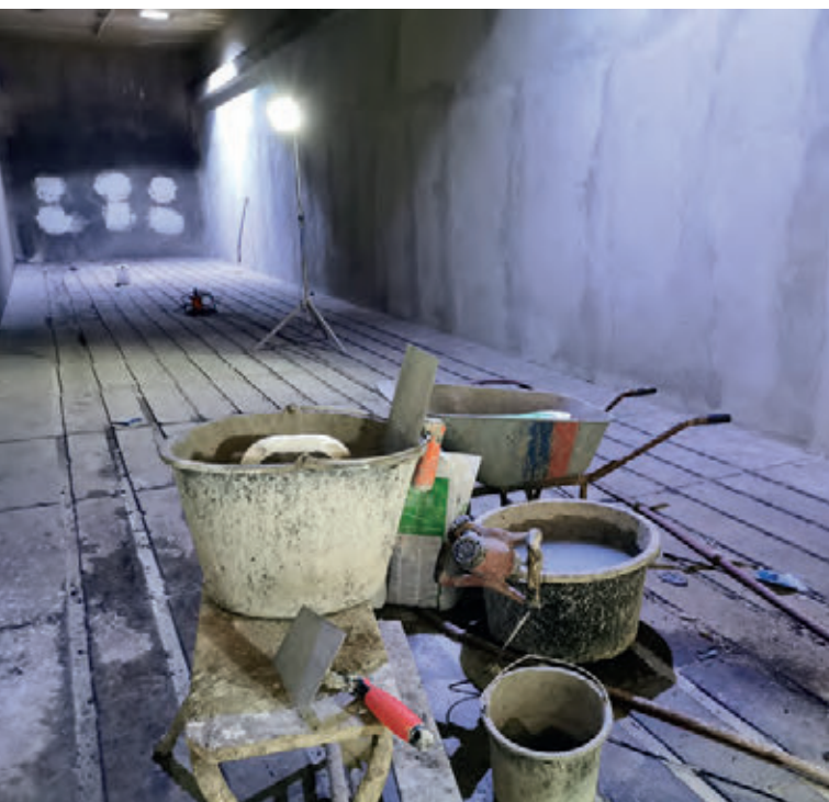
Bauwerksanierung der Rottetunnel der MBA
