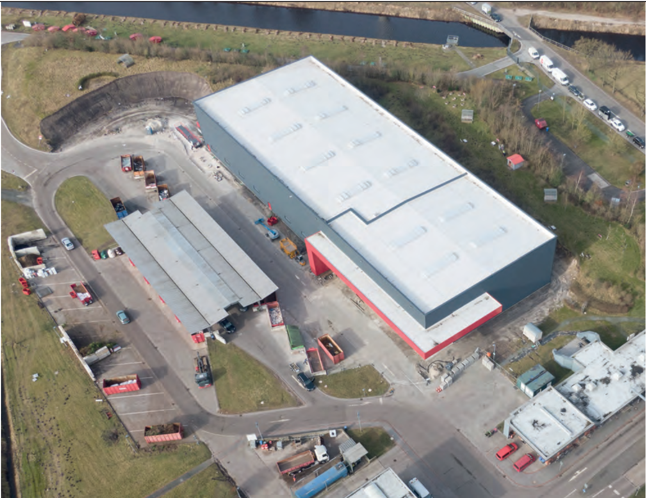
Neu errichtete Halle West und Selbstanlieferungsbereich im Entsorgungszentrum Großefehn
