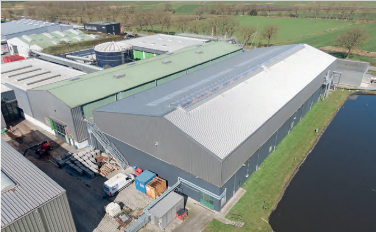
Neu errichtete Dachkonstruktion auf Rottehalle der Bioabfall-Kompostierungsanlage mit eingehaustem Biogasspeicher
