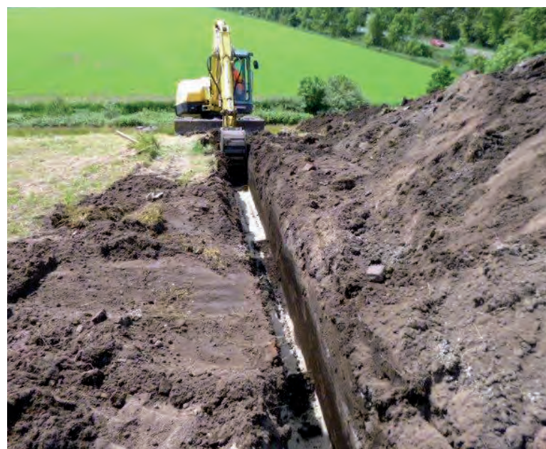
Einbau eines Dichtungskontrollsystems zur Deponieabsicherung
