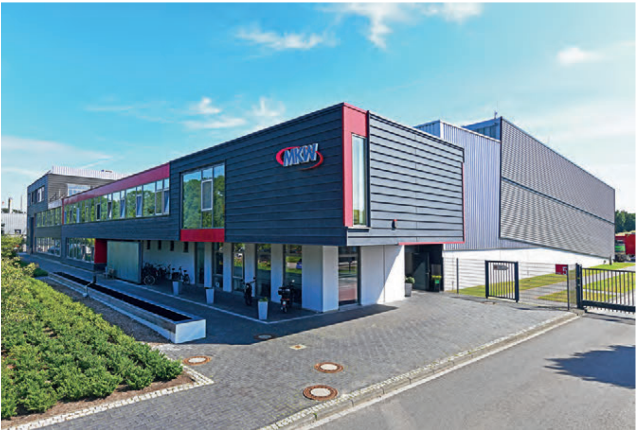
Verwaltungsgebäude der MKW am Standort des Entsorgungszentrums in Großefehn
