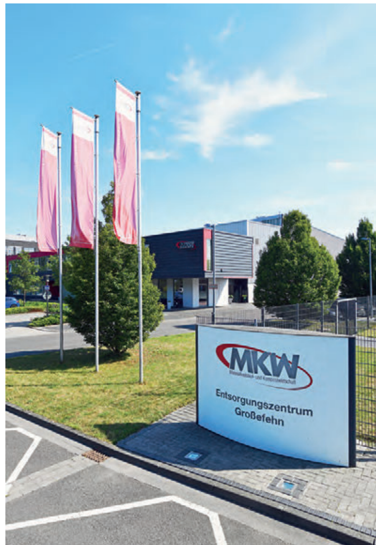
Eingangsbereich des EZG
