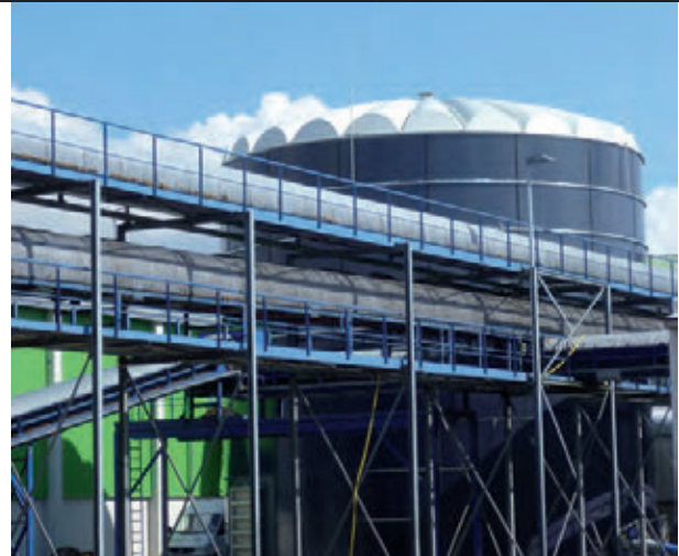
Gärresttank der Bioabfallvergärung
