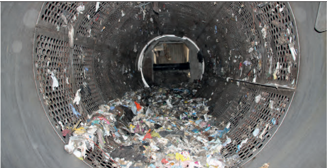
Siebtrommel der mechanischen Aufbereitungsanlage von Restabfall
