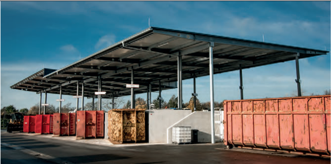
Selbstanlieferungsrampe am neuen Wertstoffhof in Georgsheil
