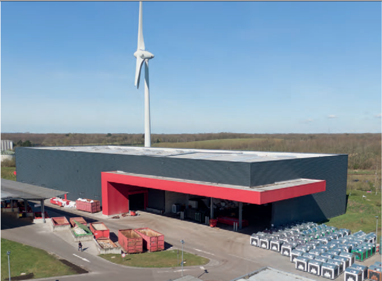
Die neu erbaute Halle West im EZG
