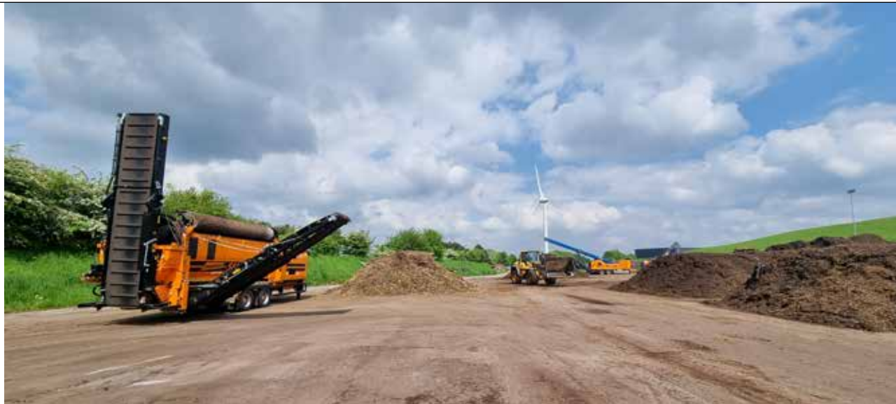
Grünabfallkompostierungsanlage im Entsorgungszentrum Großefehn
