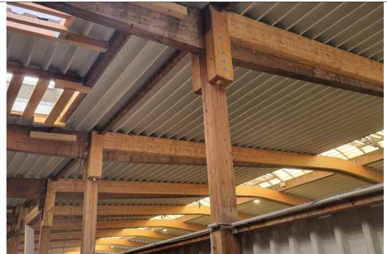
Verstärkung des Holztragwerks der Dachkonstruktion in der biologischen Aufbereitungsanlage der MBA
