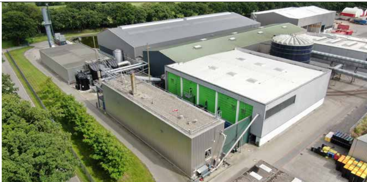
Vergärungsanlage des Kompostwerks im EZG
