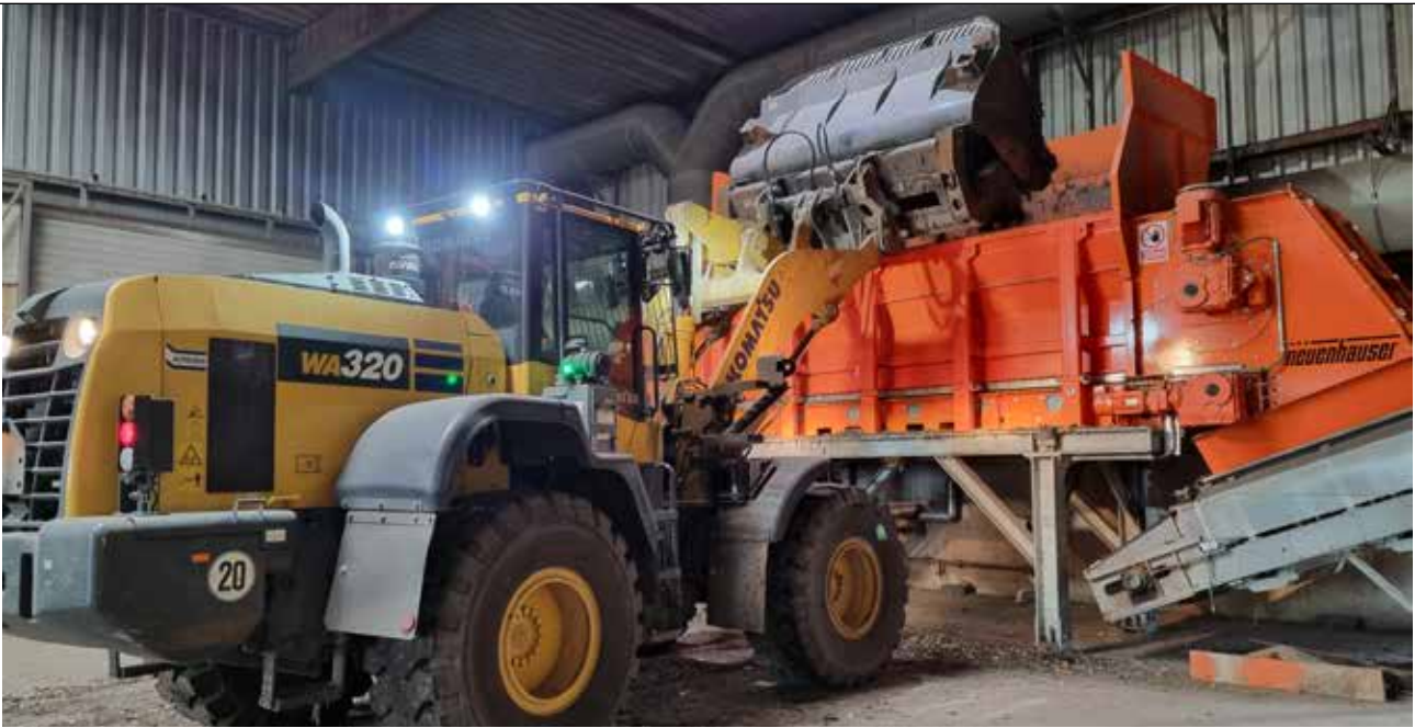
Beladung des Aufgabedosierers in der in der biologischen Aufbereitungsanlage der MBA
