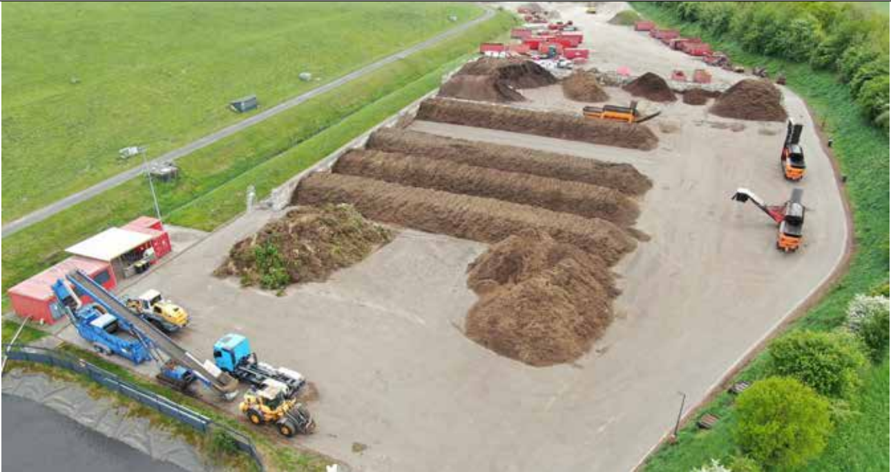
Grünabfallkompostierungsanlage am Westrand des Deponiehügels in Großefehn
